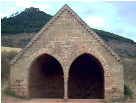
Villamayor de Monjardin (Aljibe)
