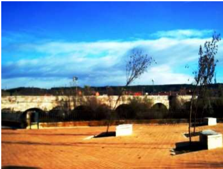
Puente sobre el río Torío
