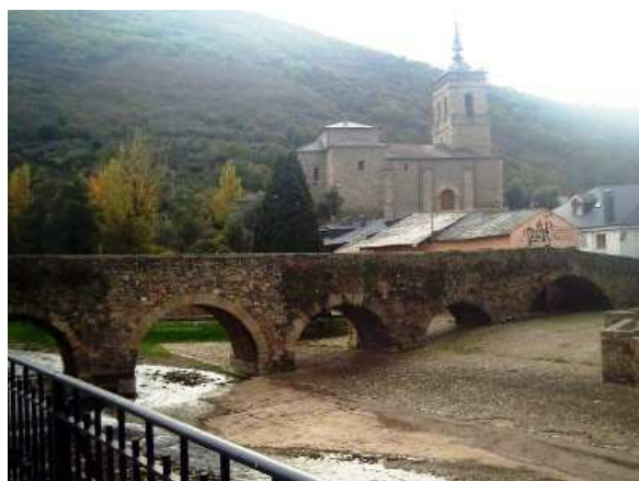
Puente sobre el río Meruelo
