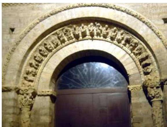
Antigua iglesia de Santiago (Pórtico)
