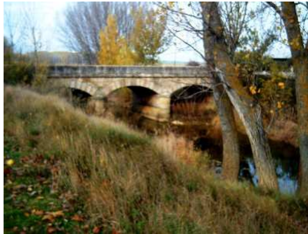
Puente de Villovieco
