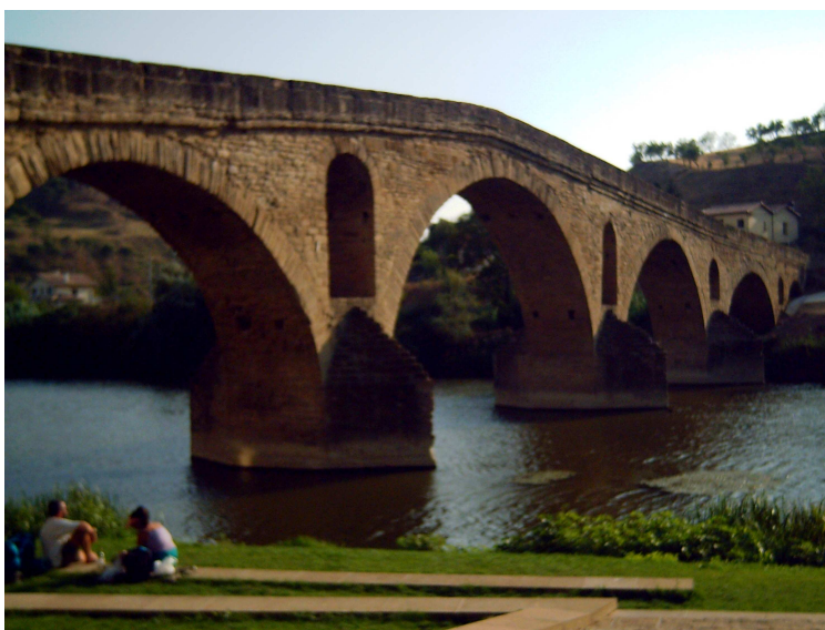
Puente La Reina (vista del puente)
