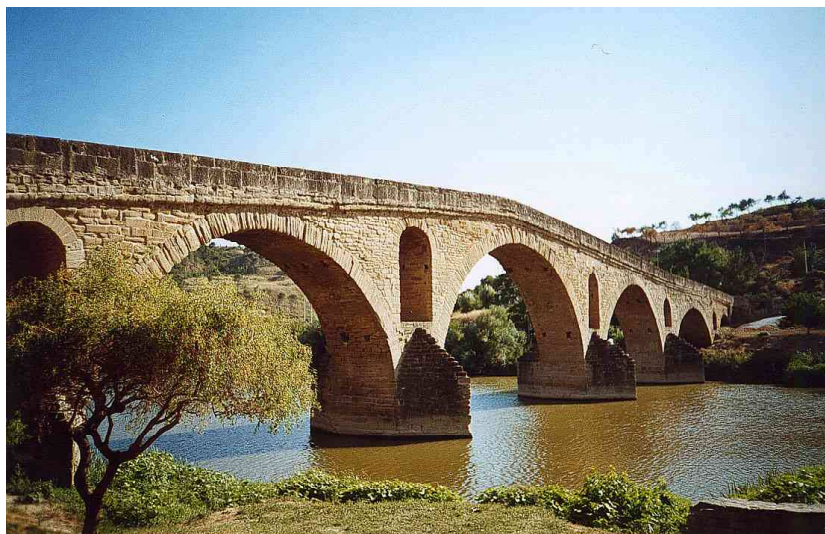
Puente La Reina (vista del puente)
