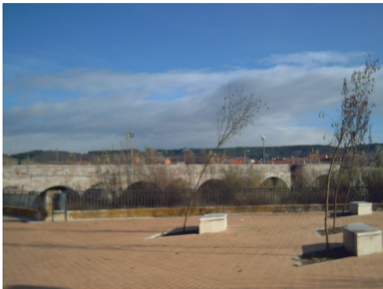
Puente sobre el río Torío
