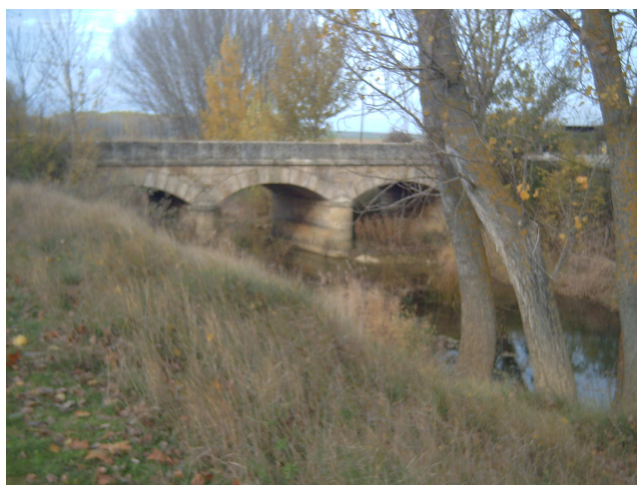
Puente de Villovieco
