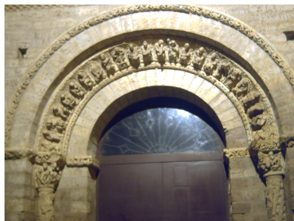
Antigua iglesia de Santiago (Pórtico)
