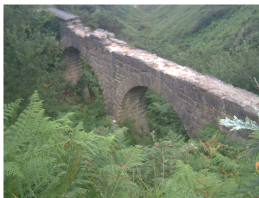
Acueducto en el monte
