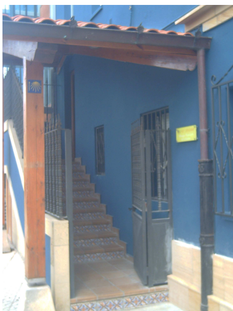
Entrada al albergue de Colindres
