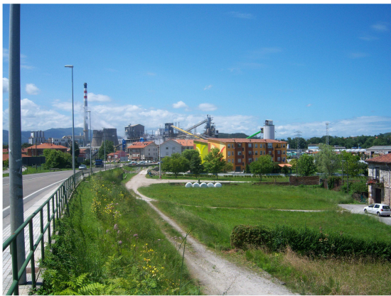
Vista del complejo industrial
