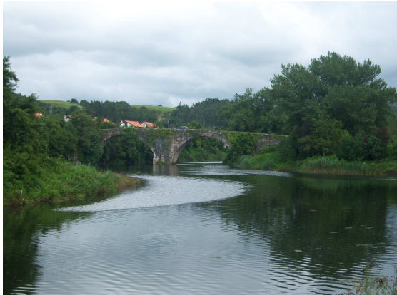
Puente medieval en Puente Arce
