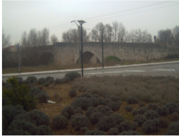
Puente sobre el Duero
