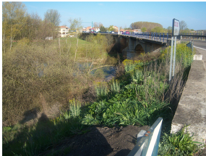
Puente sobre el río Porma
