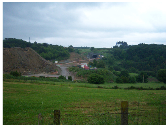
Obras del AVE
