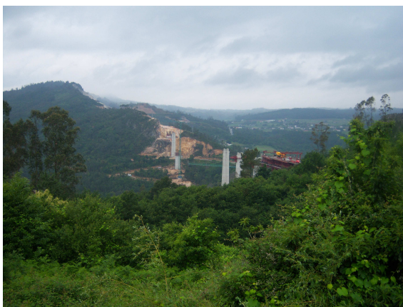
Obras del AVE
