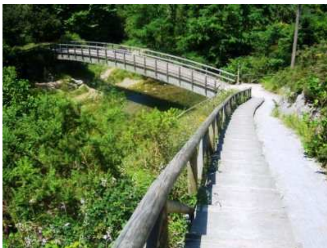
Puente sobre el río Purón
