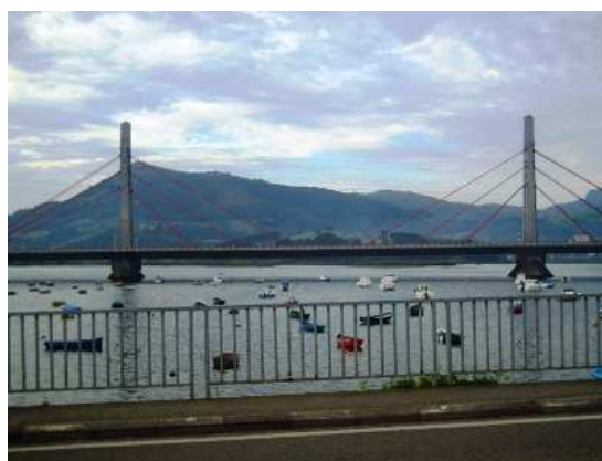
Puente sobre la ría de Treto
