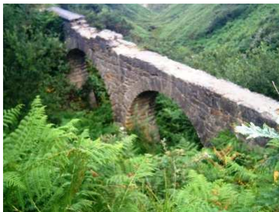
Acueducto en el monte
