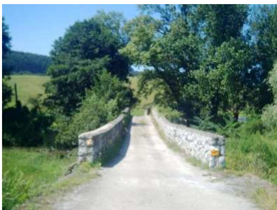
Entre los muros del puente
