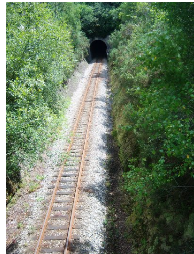
Vías y túnel
