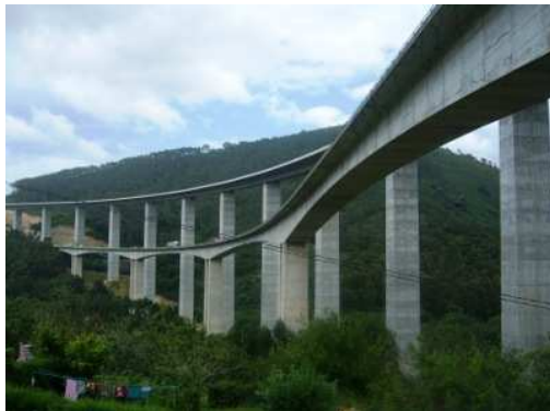
Viaducto de Luiña
